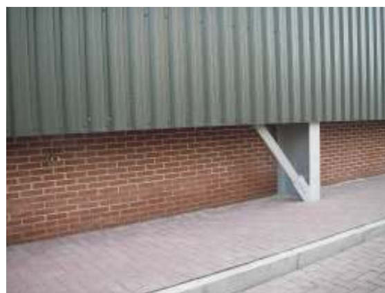
Photo 4: auvent retour du côté des volets d'entrée d'air
