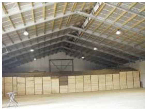
Photo 1: un bâtiment de 6.000 t déjà largement déstocké
