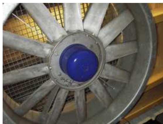
Photo 7: ventilateur EC à 12 pales sans clapet anti-retour
